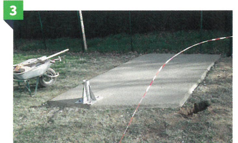
3 Réalisation d'une dalle en béton pour accueillir une cabane de jardinage afin de stocker le matériel, ainsi qu'un récupérateur d'eau pour faciliter l'arrosage des futures cultures.
