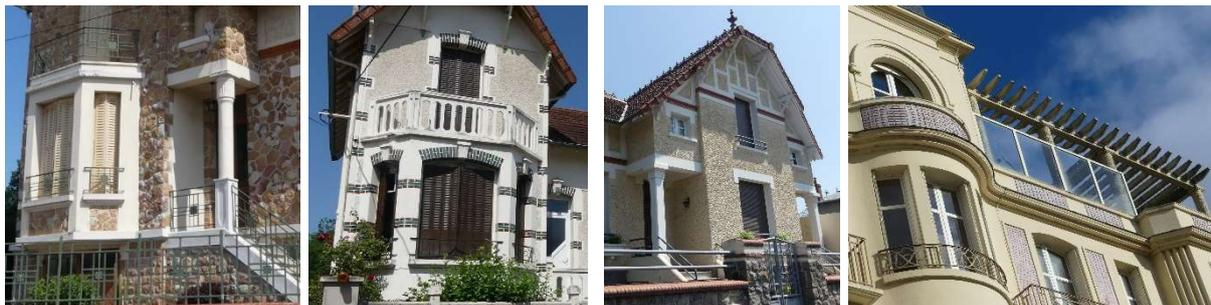
Le béton blanc en structure et en ornementation : bow-window, colonnes, garde-corps, faux pans-de-bois, moulurations et cannelures...
